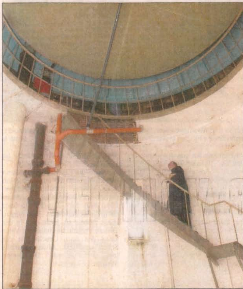
„Ab hier nur mit Blaumann“: Thorsten Brune unterhalb des Tanks.
