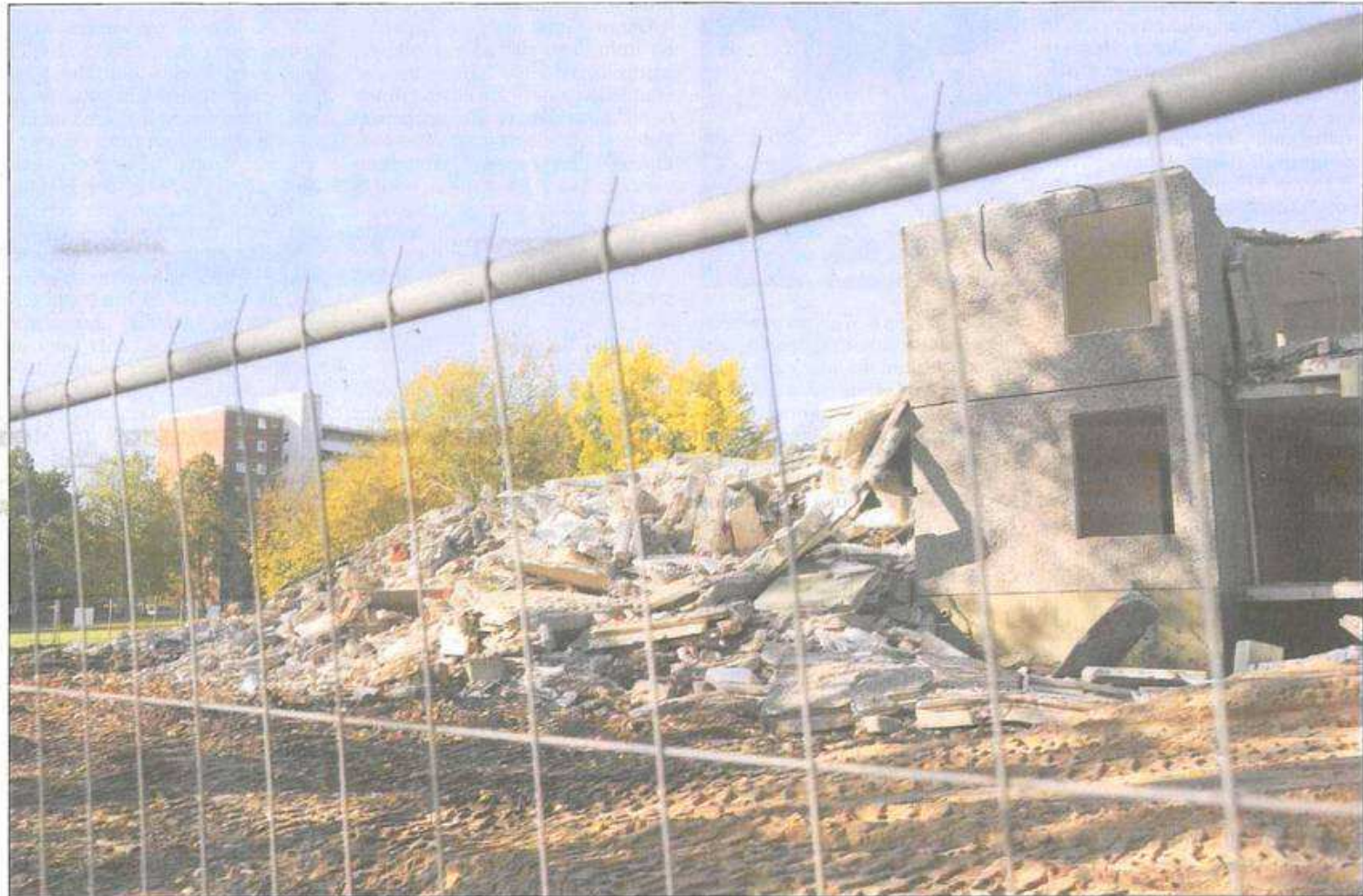
Die sogenannten Krause-Häuser in der Ferdinand-Lassalle-Straße hat die Gewoba gerade abreißen lassen. Sie gehören allerdings nicht zu ihrem Bestand, den die Abrissbagger in den vergangenen Jahren um 1000 Wohnungen gelichtet haben. Foto: Is
