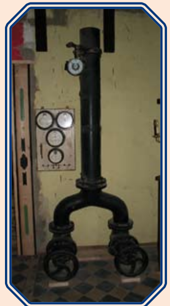
Aus der Gründerzeit stammende Rohrleitungen dienen heute als Dekoration
