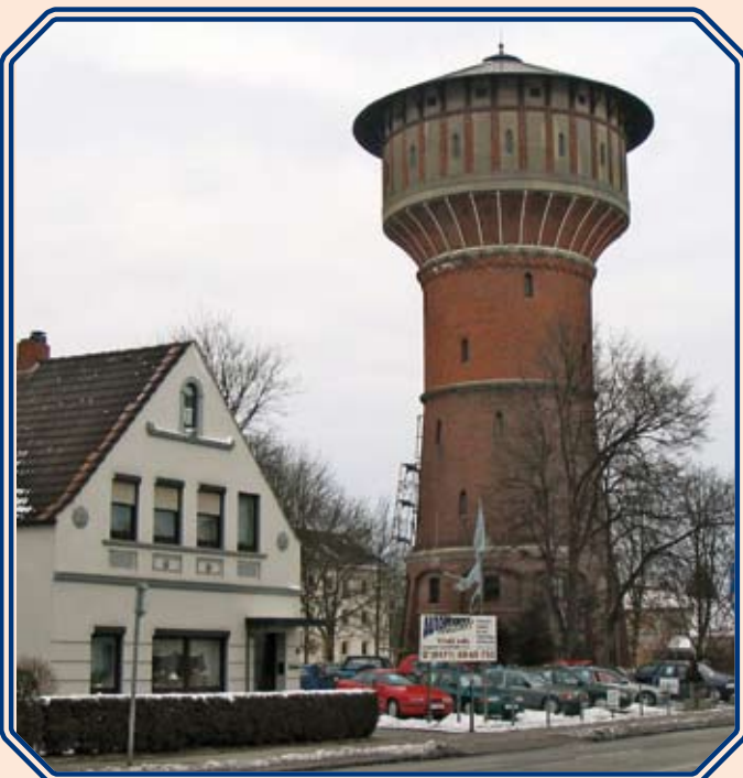
Der Wasserturm heute, Aufnahme aus dem Februar 2007
